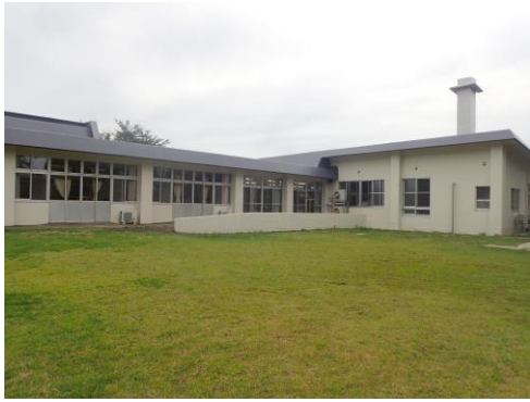
【外壁・居室東側】
