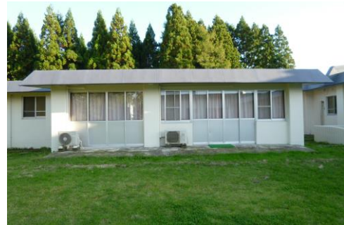
【外壁・居室北側】
