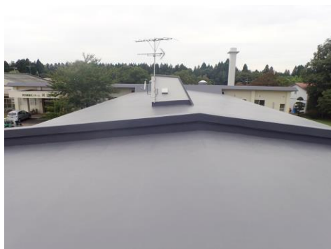
【防水・平場全景】
