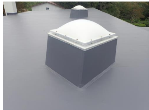
【防水・立上がり部】
