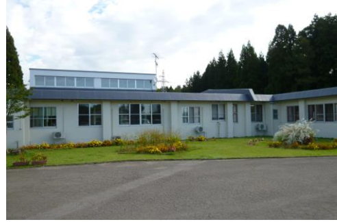
【外壁・居室西側】
