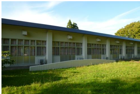
【外壁・居室南側】
