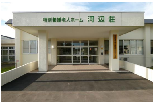
【外壁・施設正面】
